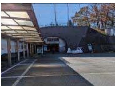
トンネルの駅正面 トンネル焼酎貯蔵庫
