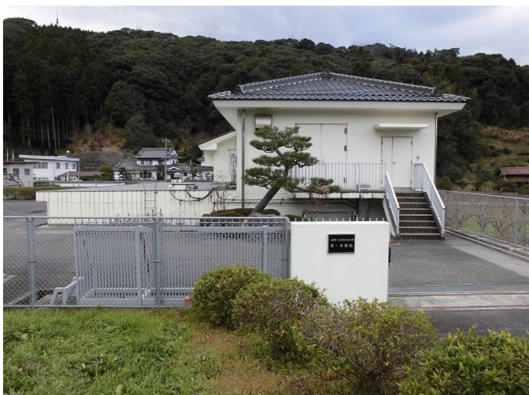
浜田市工業用水道事業 第1水源地
