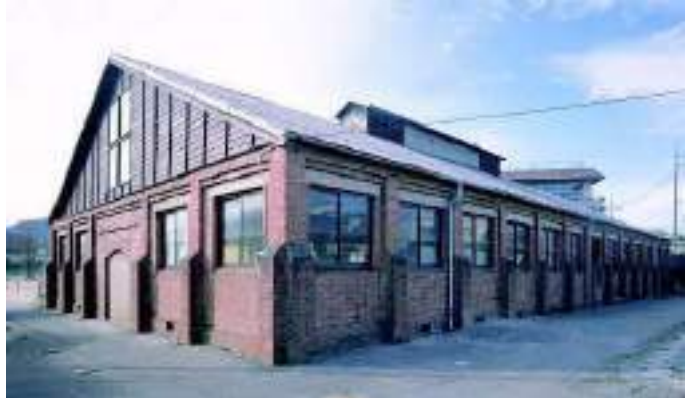
写真 2-1 浜田市立第一中学校屋内運動場
