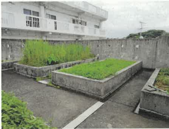
屋上ではハーブの栽培などがされている
