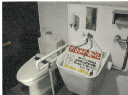
トイレカー内部(多目的トイレ)
