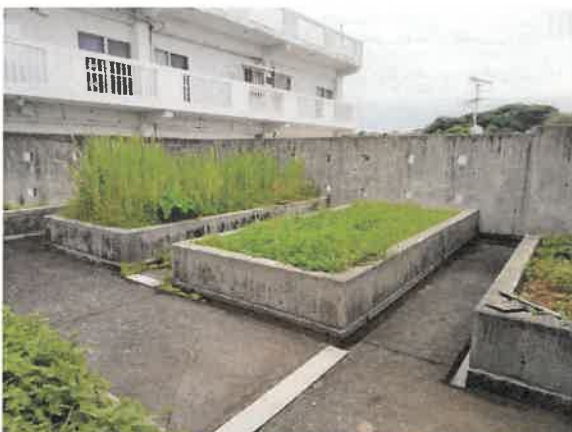
屋上ではハーブの栽培などがされている
