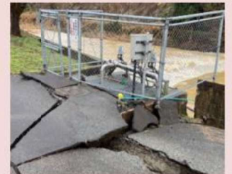
水道の復旧 (被災した浄水場)
