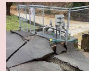
水道の復旧 (被災した浄水場)
