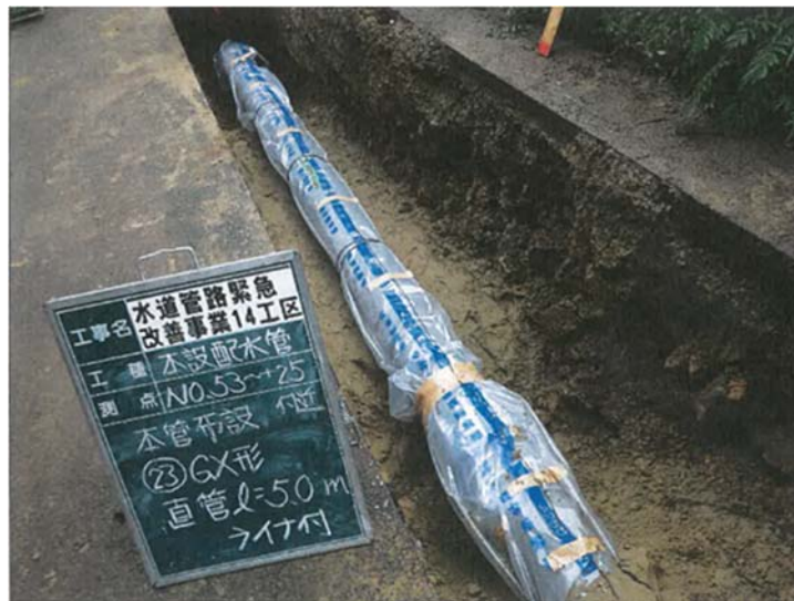
耐震管布設状況写真
