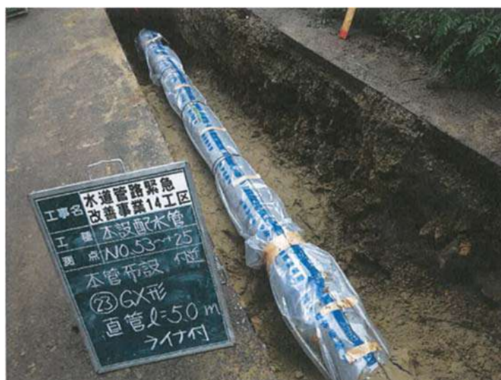
耐震管布設状況写真
